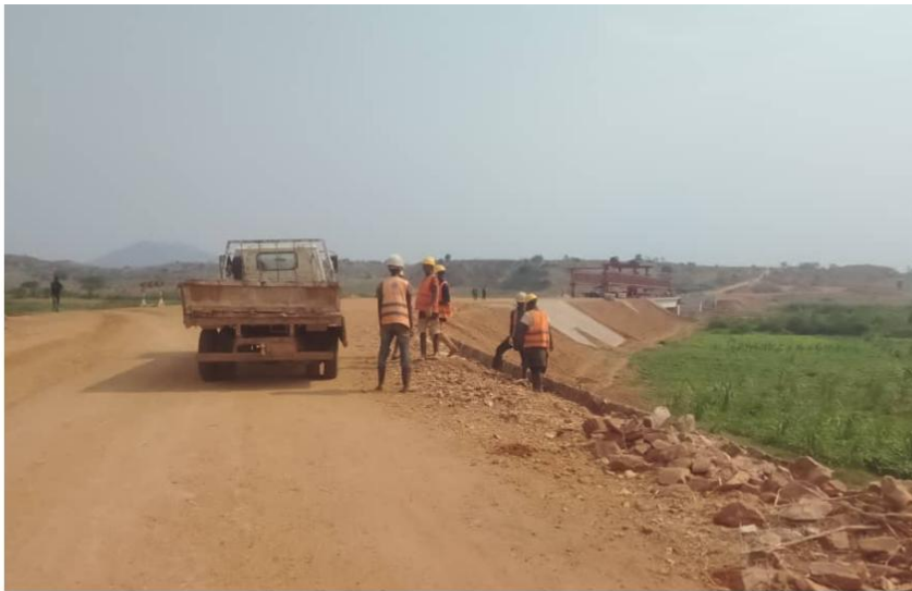
Photo 10 : Les travaux du pont entre Buganda (Burundi) et la RDC,
