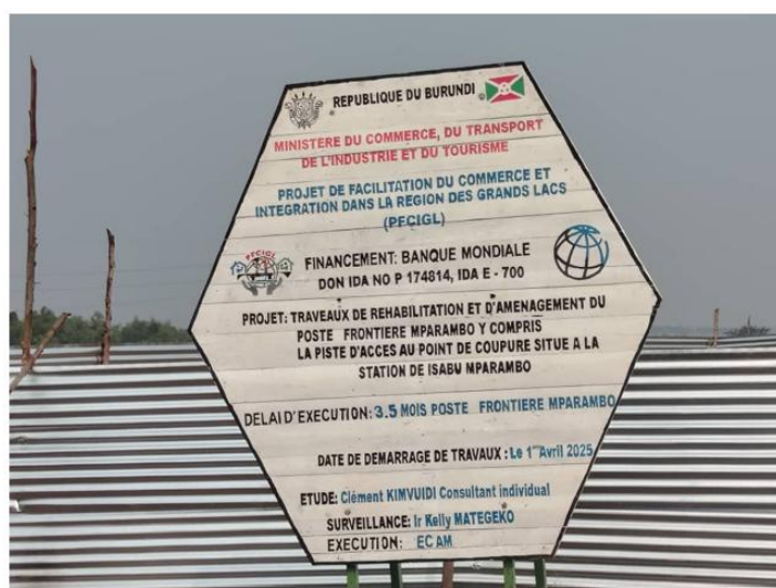
Photos 12 : Les travaux préparatoire du PF de Mparambo
