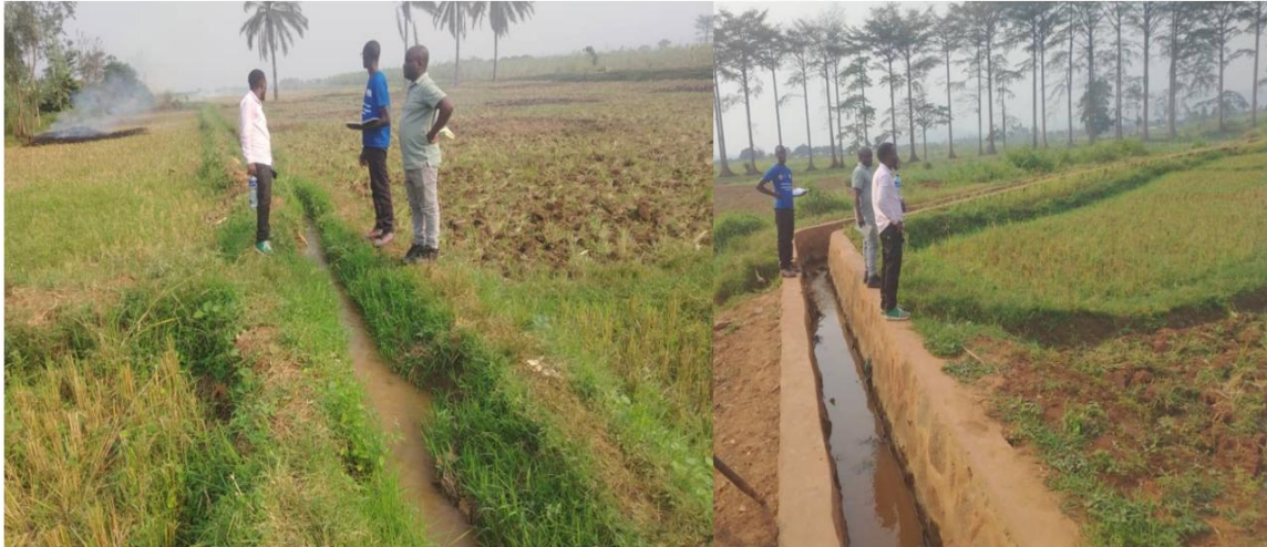
Photos 5 : Des canaux d'irrigation empiétés par le tracé de la voie d'accès
